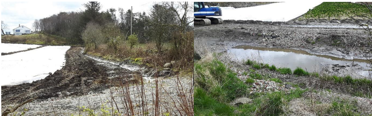
Figur 58: Venstre: Det vart graven avskjeringsgrøfter rundt teig 35 i april 2017. Høgre: Utløpet til dammen er heva.
