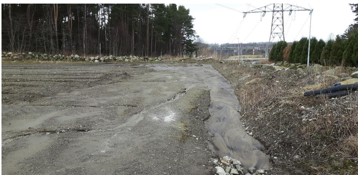
Figur 78: Sedimentasjonsområdet i nedre del av teigen Sægrov er i dag oppfylt av fine partiklar, og kapasiteten er sprengt. Ein sedimentasjonsdam vil etablerast her og forbetre kapasiteten.
