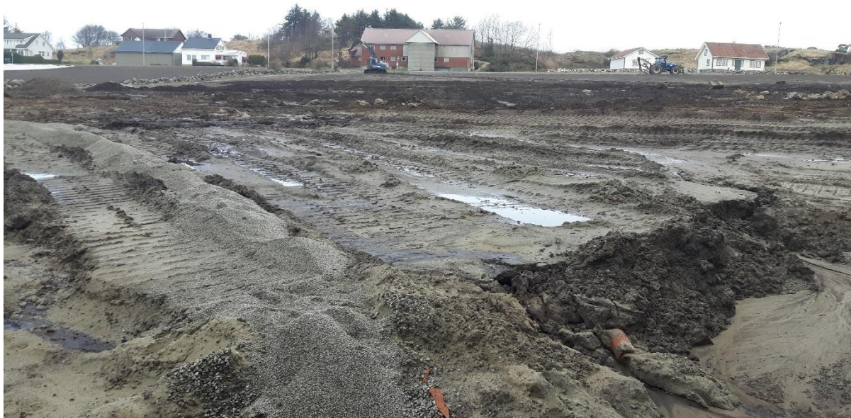
Figur 14: I Sandvika var teig nr. 2, "Kopperdal/Tungenesveien" (gnr/bnr 53/14) under drenering.
