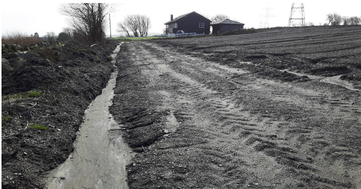
Figur 77: Vollen mot Alvasteinsvegen leier vatnet over sedimentasjonsområdet.
