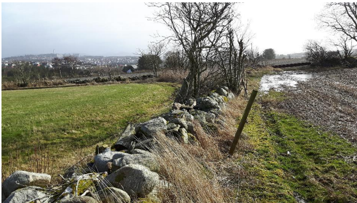
Figur 85: Avrenningssituasjonen på Vidar er i følgje grunneigar endra etter at det vart laga opning i steingarden (gnr/bnr 40/24) og graven ei grøft/voll i hjørnet på naboteigen (grasdekt, gnr/bnr 40/57). Dette gjer at overvatn frå marka med kornproduksjon renn inn på grunneigars mark, og gir ytterlegare avrenning frå den brakke jorda.
