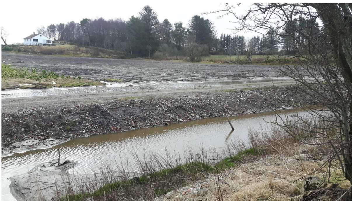
Figur 57: I nedre del av teigen 35 er det etablert ein sedimentasjonsdam. Ved stor avrenning har overvatnet runne over driftsvegen på bildet. Overvatn samlast også opp over driftsvegen, og dreneringa er under utbetring.
