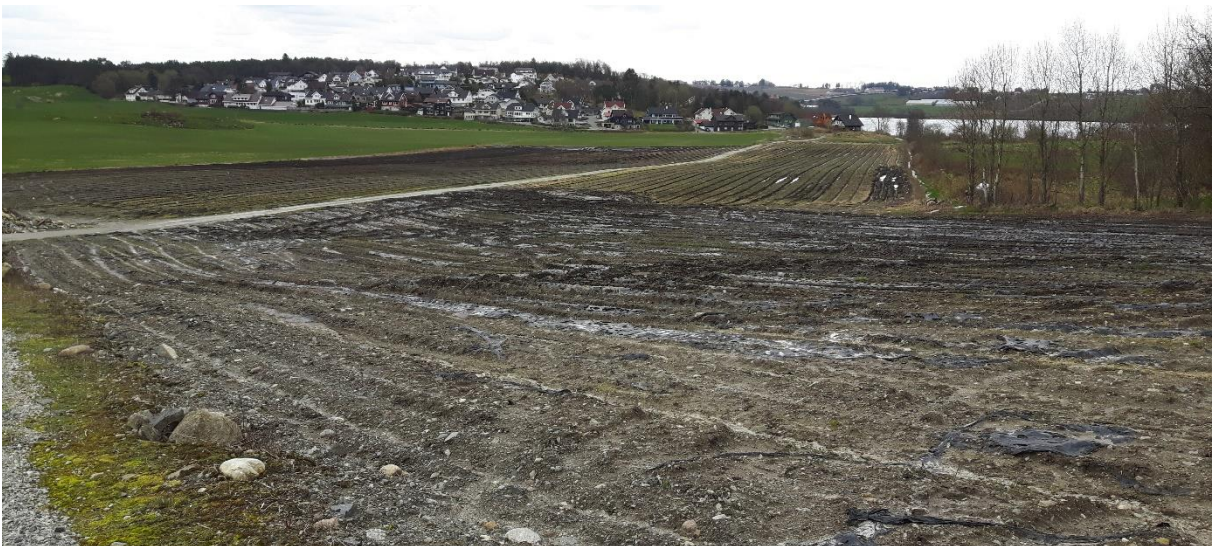
Figur 68: Teig 39 har god helling i øvre del. Det går en kanal langs sida til høyre. Marka heller bort frå kanalen, og ned mot anleggsvegen.
