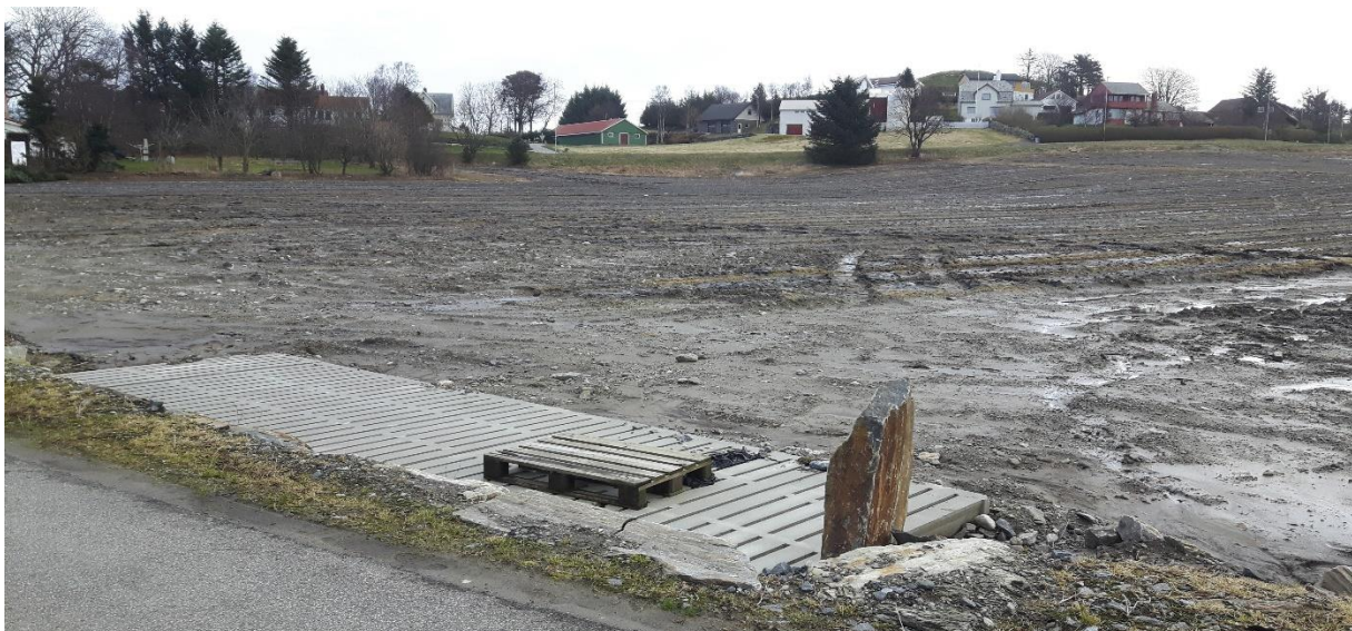
Figur 59: Ein sedimentasjonsdam med rist som sikring er etablert i nedre del av teig 36. Dreneringa til dammen er under utbetring.
