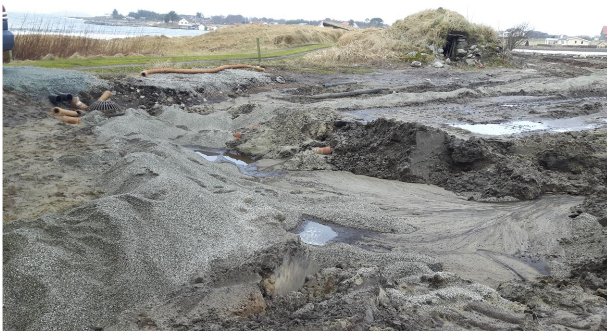
Figur 15: I nedre del av teig nr 2, "Kopperdal/Tungenesveien" (53/14) går ein veg inn til ei privat hytte. Vatnet ledast i dag i samlerøyr gjennom grus, under veggen og ut i sjøen i Sandvika. Ein ny anleggsveg skal byggast mot potetkjellaren (der bildet er teke frå). Ein sedimentasjonsdam for overflatevatnet vil etablerast mellom dei to vegane.
