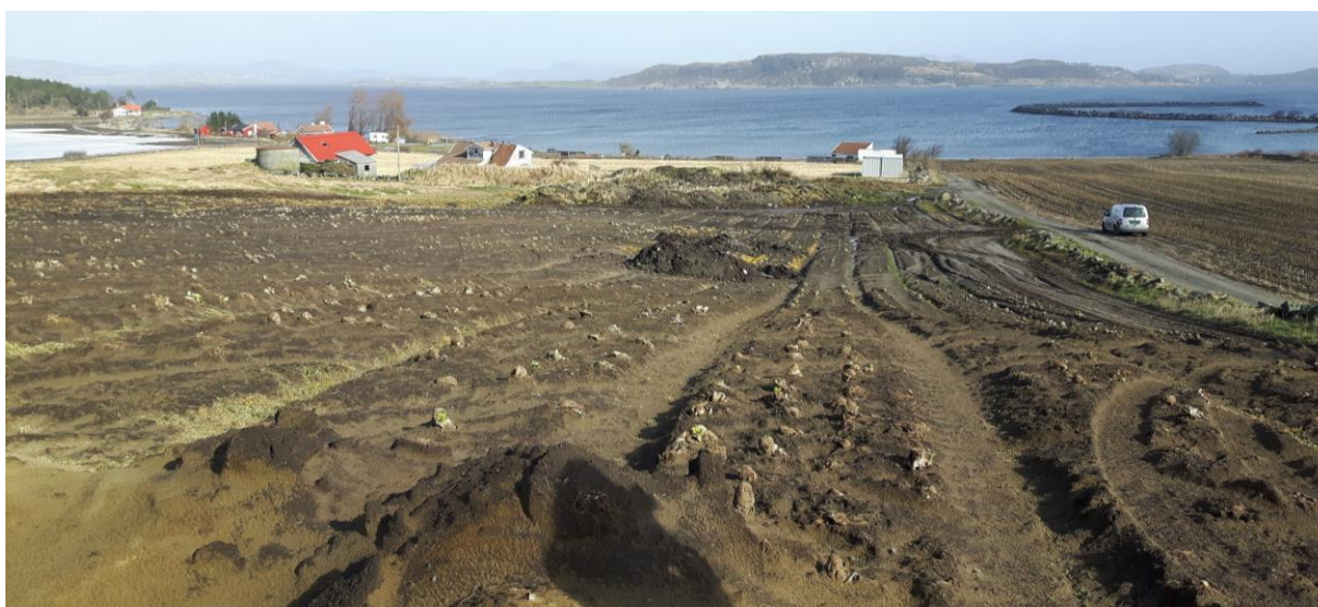
Figur 10: Fjellet ligg grunt i delar av marka, og skal sprengast vekk før heile teigen drenerast på nytt. Det skal etablerast ein sedimentasjonsdam i hjørnet av teigen i forkant av konteinaren på bildet.
