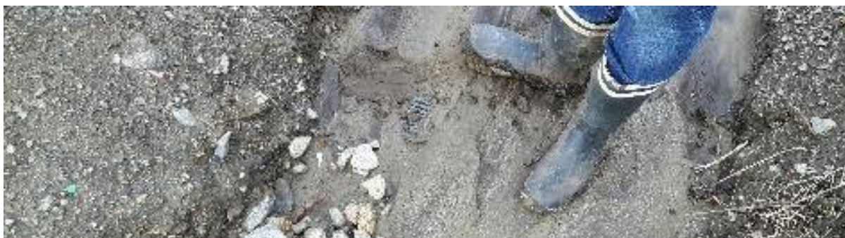
Figur 76: Drensrøyra som går under innkøyrsla til teigen er i dag dekket av finpartikulært materiale. Området har i dag behov for vedlikehold.
